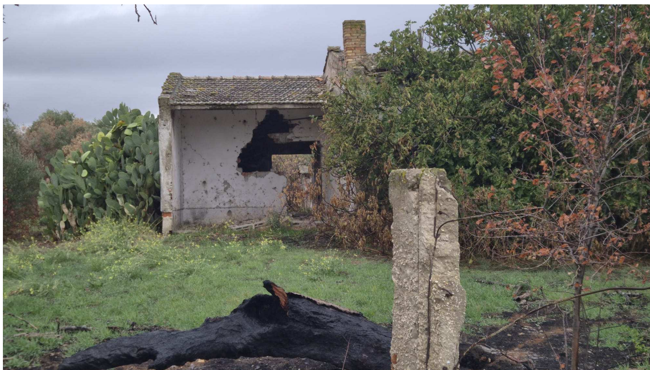
FOTO N. 3-4 - Terreno al foglio 3 part. 108 e ruderi part. 106 e 107.
